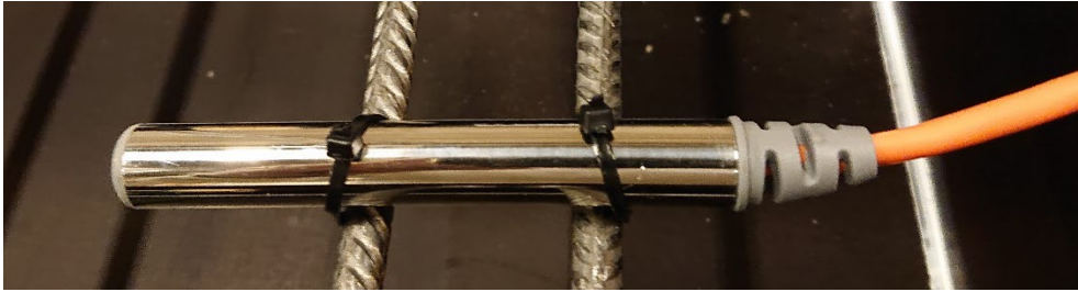
Figur 3.2 Sensohives fuktsensor monterad på två armeringsjärn.
