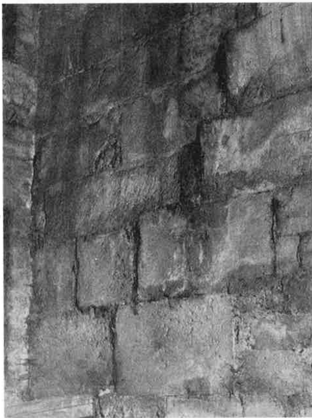
Fig. 47. Skarv efter äldre genombrytning av transeptmuren synlig från vinden över södra sakristian.
