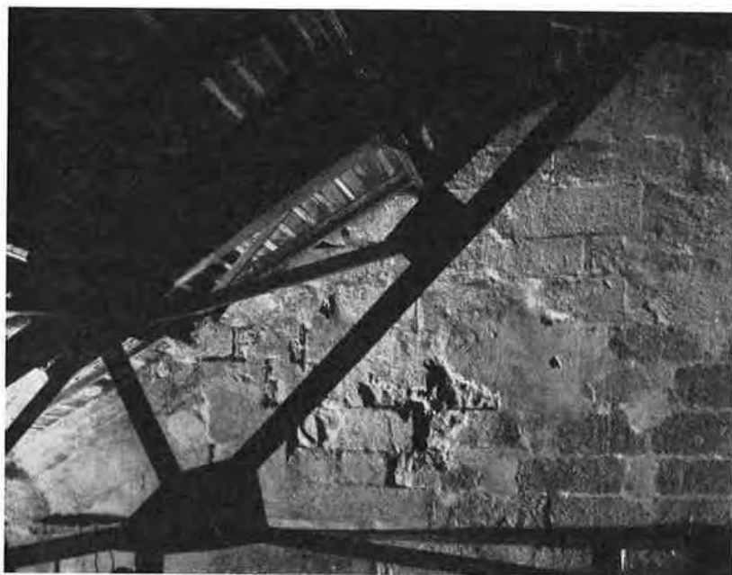
Fig. 4. Äldre murparti i norra sidoskeppsvindens östra vägg.
