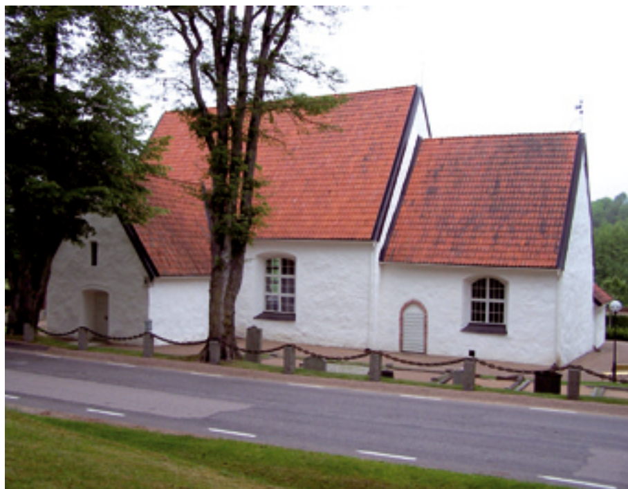
Fig. 5:9. Även under senmedeltiden uppfördes det kyrkor med romanskt, smalare korparti. Dendrokronologiska undersökningar har visat att kyrkan i Edestad i Blekinge byggts under förra hälften av 1400-talet, medan vapenhuset och sakristian tillfogats senare under medeltiden (K. Andersson 1997:48ff; Ullén 2002:26ff). Edestads kyrka var under senmedeltiden en viktig vallfartsort, och det är med största sannolikhet inkomster från denna vallfart som bekostat byggnaden. Detta visar att romansk planform inte enbart skall förknippas med aristokratiska intressen (Foto: Henrik Sendelbach, juni 2005).
