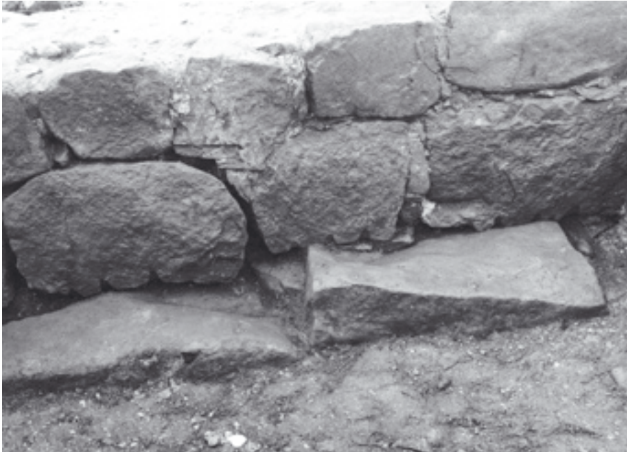
Fig. 9:3. I Övraby kyrka kan man se hur murverkets stenar spjälkats med hjälp av kilar. Foto från utgrävningen 1935-1936 (Bild: ATA).
