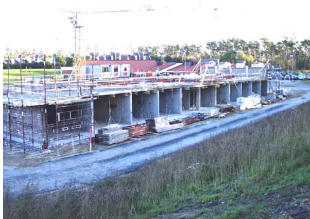
Figur 9.2 Hotelldelen under bygnation. Plattbärlaget har just monterats.
