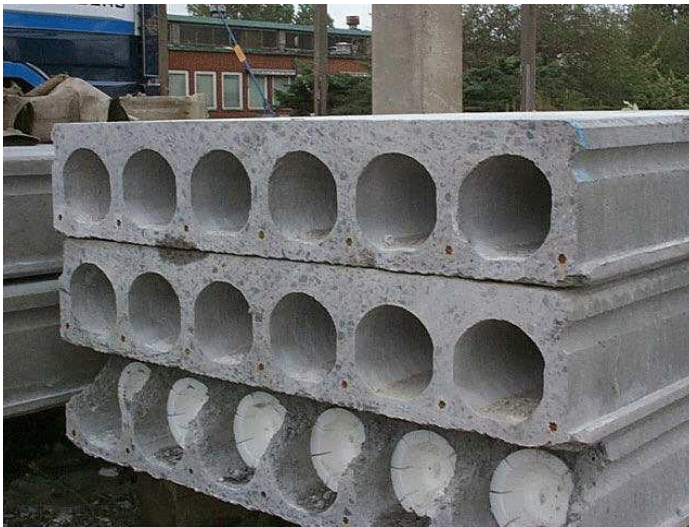
Figur 8.1 Prefabricerade håldäcksbjälklag HD/F. (Foto Skanska Prefab)
