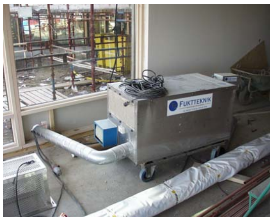
Figur 9.12 Sorptionsavfuktare.
