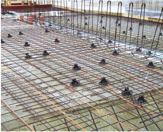
Figur 9.8 Elslingor i bottenplattan.
