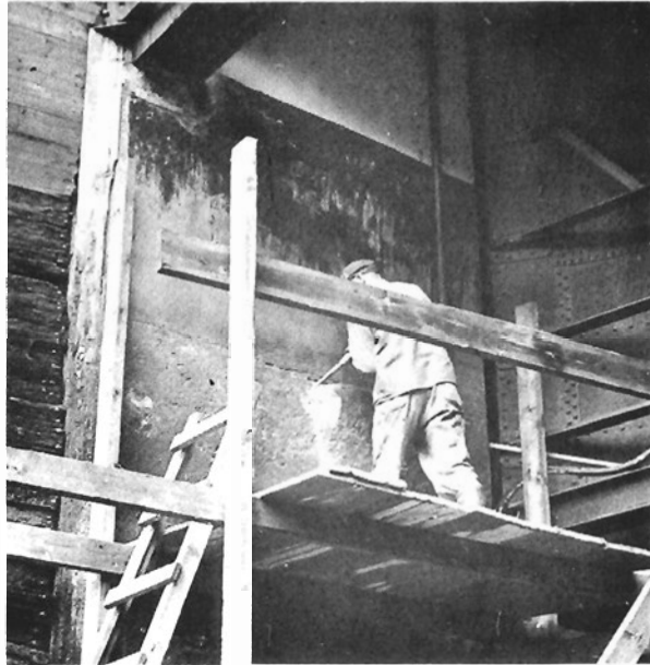
Fig 18. Bergvik. Friläggning av armeringen vid en fog inom vattenlinjenivån vid intaget till en av turbinsumparna.
