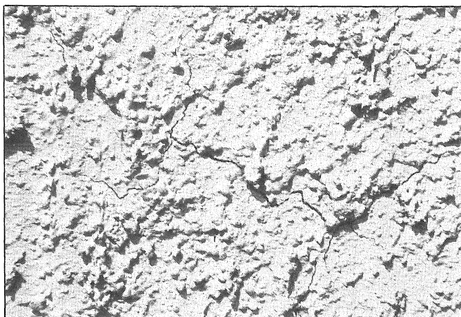
FIG. 5:3. Sprickbildning i ytskiktet.
