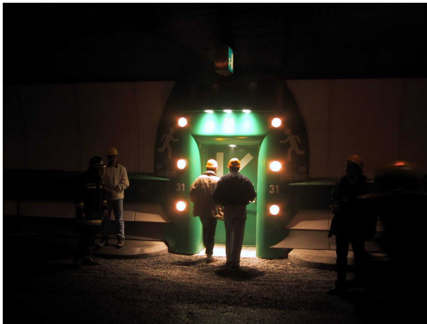
Figur 2 Utformning av utrymningsväg i tunnel.
