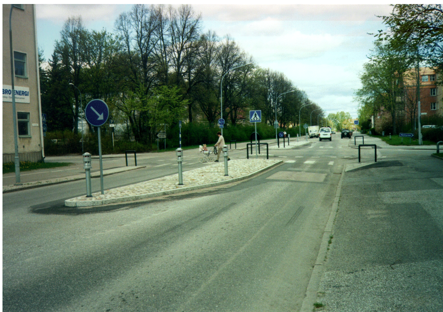
Figur 6.2 Korsningen Älvtomtagatan/Karlsbgatan i Örebro med vägkuddar, avsmalning av körbanan, långa och breda mittrefuger, handräcke och belysningspålar.
