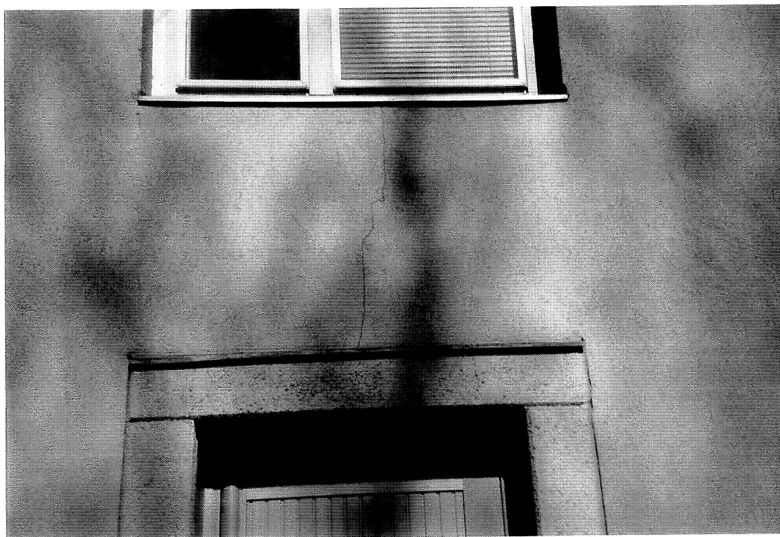
FOTO 7. Vertikal spricka mellan fönster i puts på isolering.
