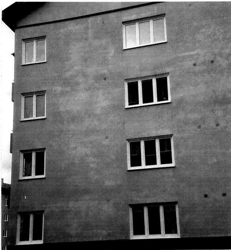
FOTO 14. Missfärgningar på CD-färg.
