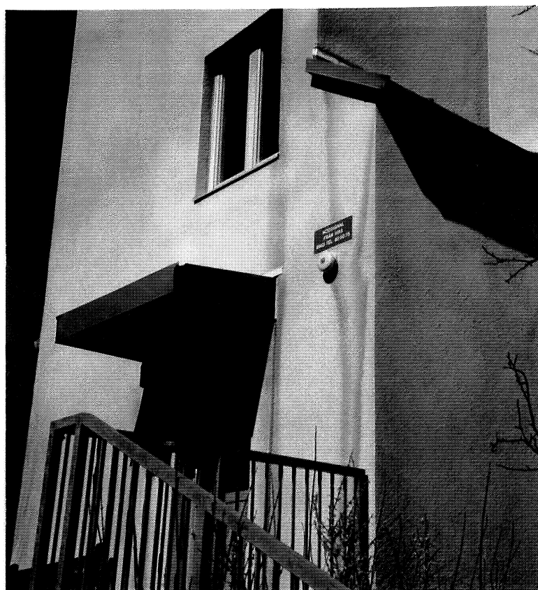
FOTO 8. Missfärgningar (rinningar) på KC-stänkputs.
