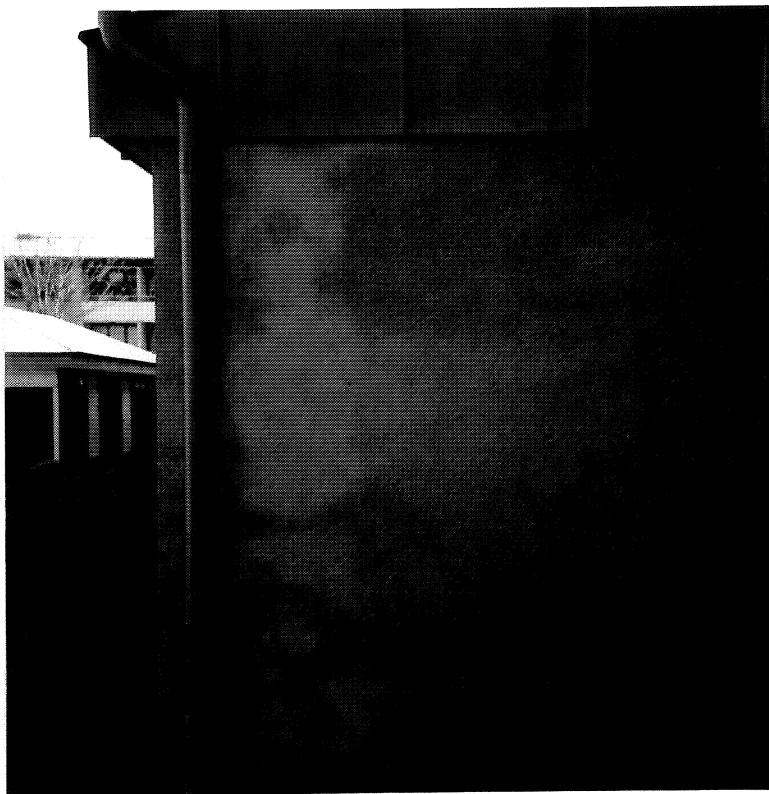
FOTO 12. Missfärgning (kalkutfällning) på ny KC-puts.
