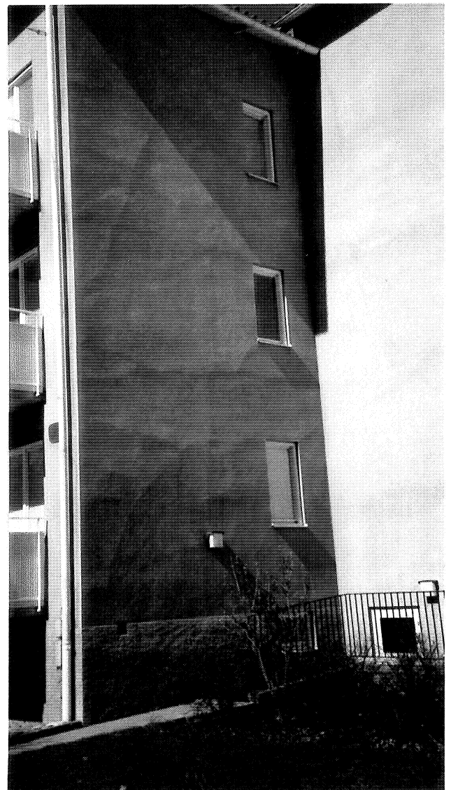
FOTO 4. Sprickor på fasad med puts på isolering.
