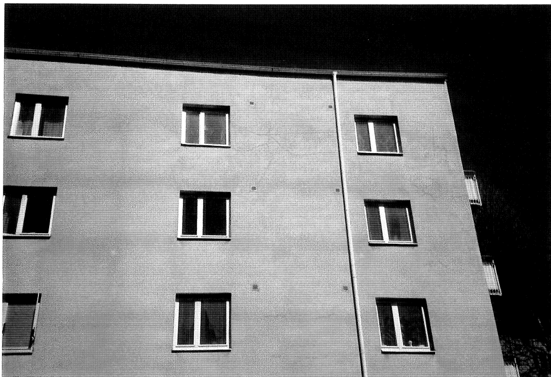
FOTO 9. Missfärgningar vid bomlagsskarvar på KC-stänkeputs.
