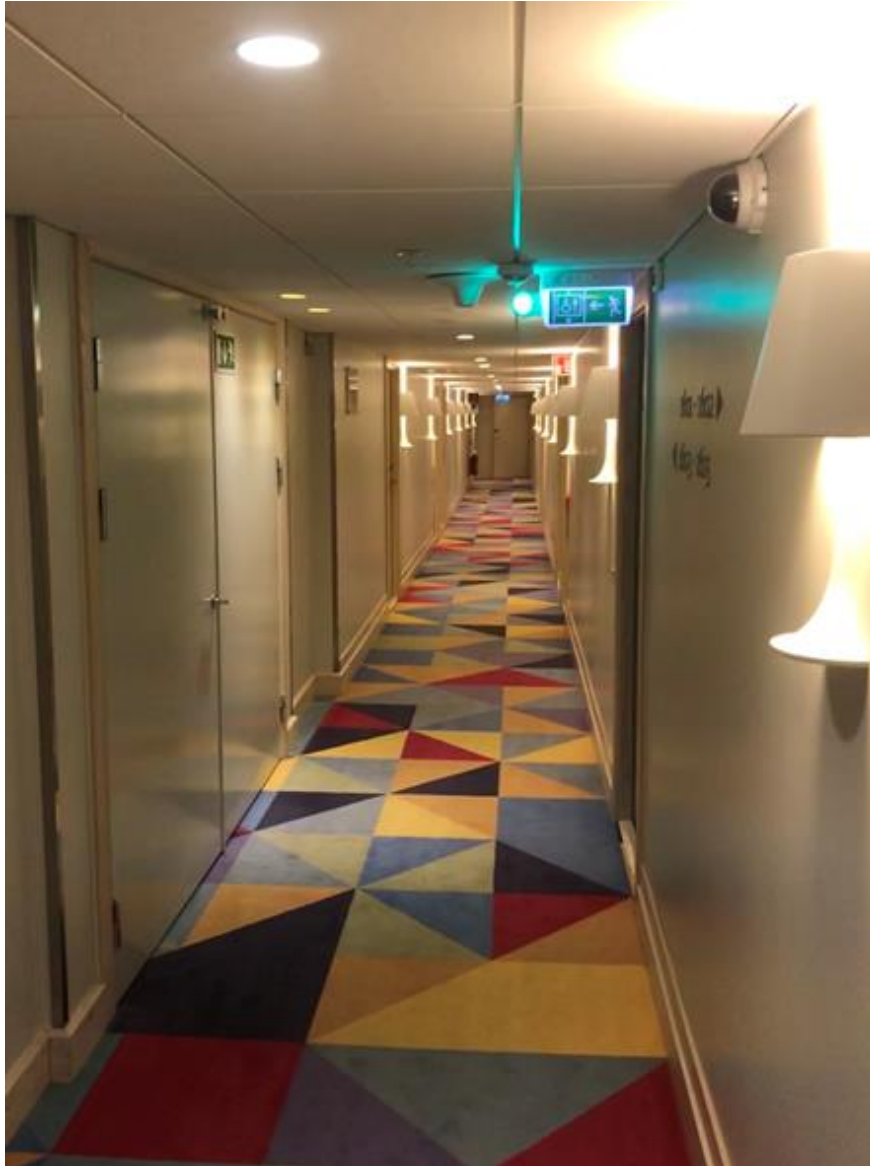
Figur 9. Skyltningen med blinkande grön lampa sedd i hotellkorridoren.
