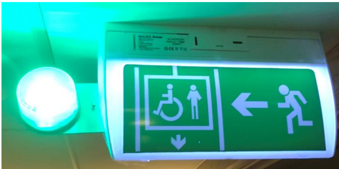
Figur 8. Skylten till hisshallen kompletterad med blinkande grön lampa.
