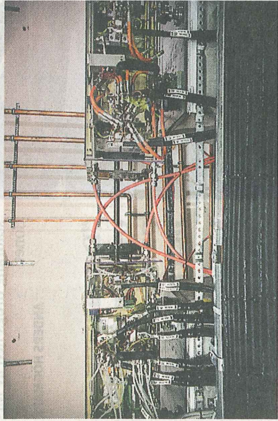
Kylanläggningen ska hålla strålrören i rätt temperatur. Energin från kylvattnet ska sedan användas till fjärrvärme.
