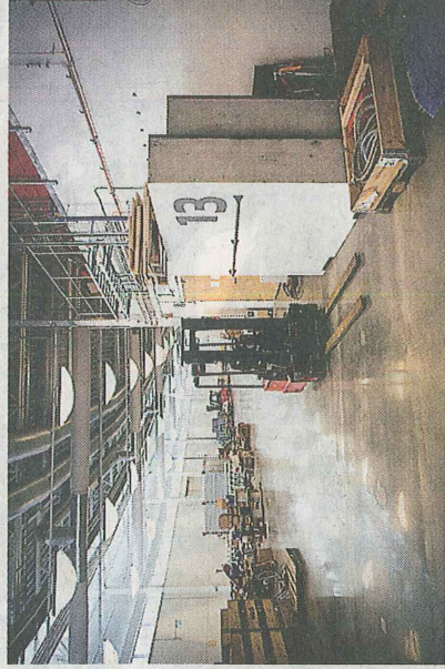
Betongblocken som ska användas för att stänga till dörröppningarna till stråltunneln är lika tjocka som väggen.
