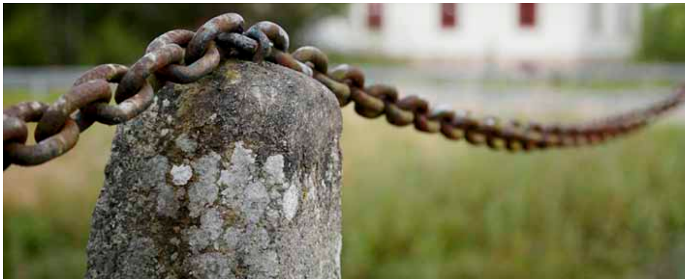
Detalj av broräcket vid stenvälsbron vid Örsled.
