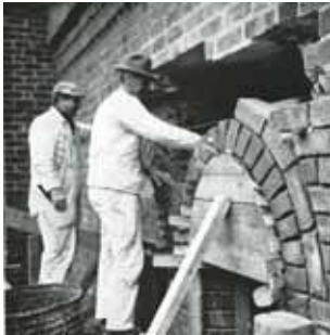
Figur 18. Arbete med att åter-skapa klostrets medeltida fön-steröppningar på 1960-talet.
