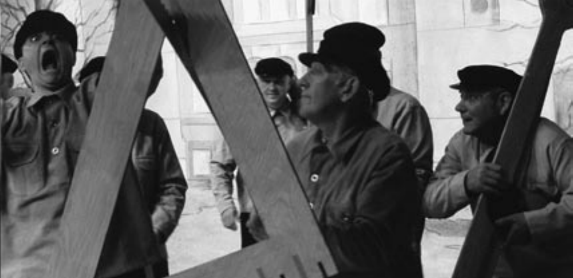
Sekelskiftet. Byggnadsarbetare. Ett blomstrande samhälle, snyggt och rent och dessutom socialt homogent.
