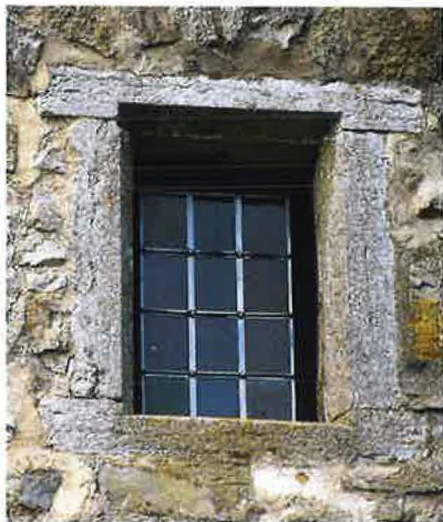
Fönster på norrfasaden, första våningen. Omfattning av gotländsk kalksten. Foto Lars Berggren 1997.
