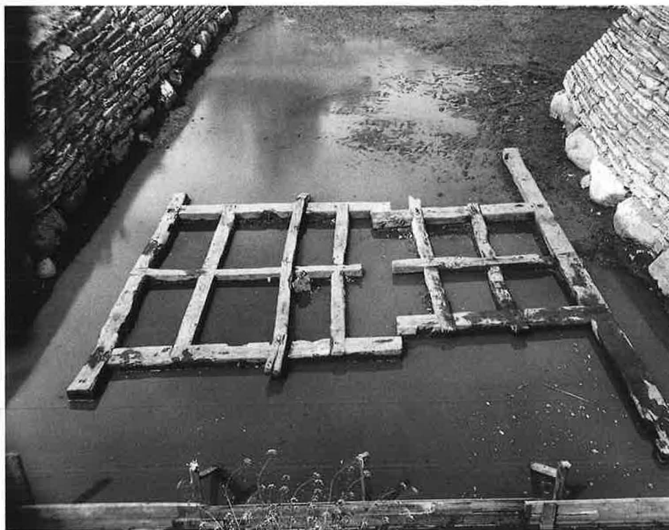
Rustbädd till vindbryggan. Foto Gunnar Svahnström, från utgrävningen 1935-37. ATA, Stockholm.
