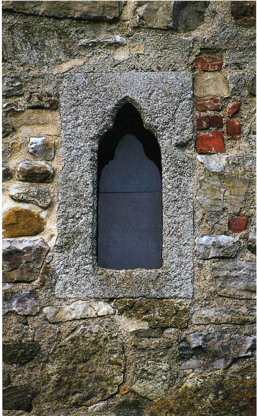
Fönsteromfattning i gotisk form, av gotländsk kalksten. Sydfasaden. Genom detta fönster leds ljuset in i trapphuset. Foto Lars Berggren 1997.
