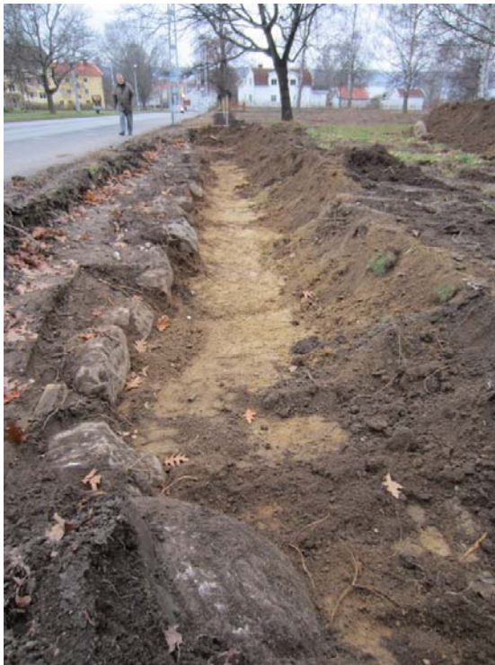
Figur 6. Fundament till avgränsningsmur i söder mot landsvägen 2011. Foto: Jönköpings läns museum.
