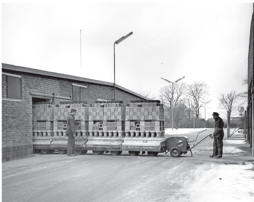
Tunnelugnsvagnar lastade med klinker körs till sortering.
