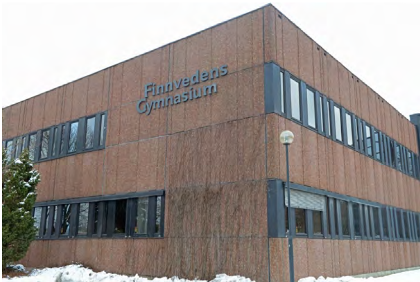
Finnvedsskolan/Finnvedens gymnasium i Värnamo som färdigställdes 1969. Foto: Magnus Grahn.
