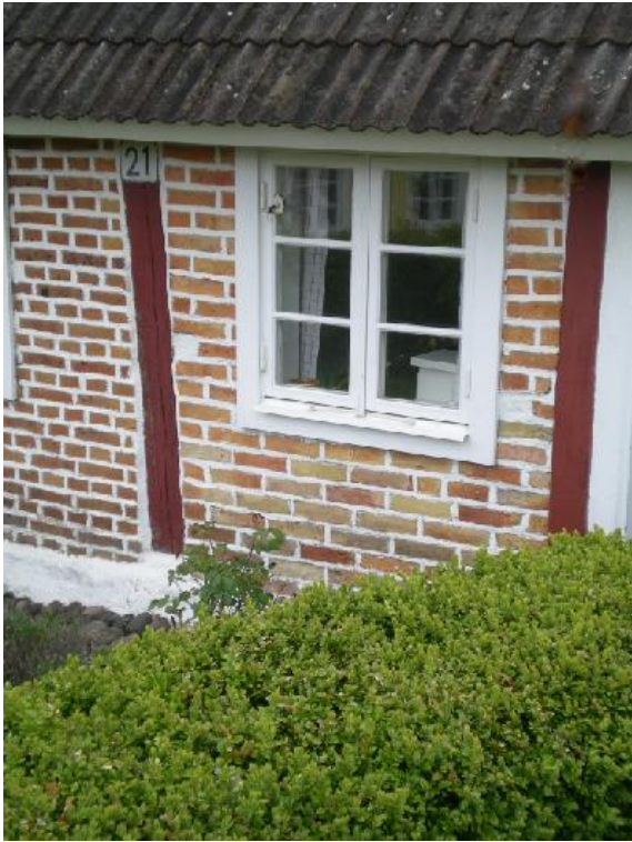
Bild 3. Korsvirke med tegel som väggfyllnad. Foto. Arild.
