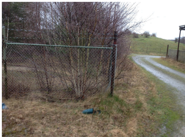
Fig. 4. Metallhydroxiddeponin som inhägnats med industristängsel och låst grind. I bakgrunden syns deponin som en kulle. Byggnationerna till höger i bild utgörs av minkgödselupplaget. Foto: Daniel Persson.
