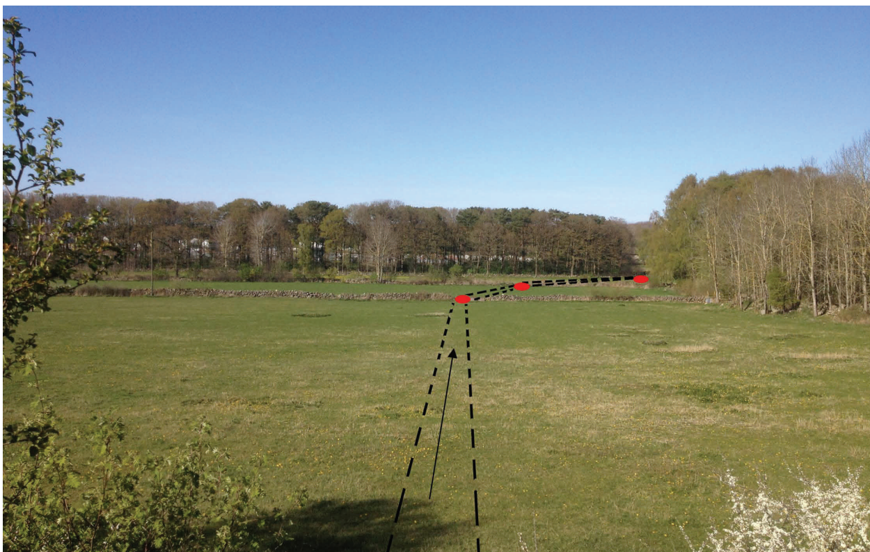
Fig. 3. Dräneringsrörens läge som sammanbinder dräneringsbrunnarna. Brunnarna är markerade med rött och pilen markerar strömningsriktning. Bilden är tagen från bentonitvallen i nordlig riktning. Se även fFig. 1 för översikt.
