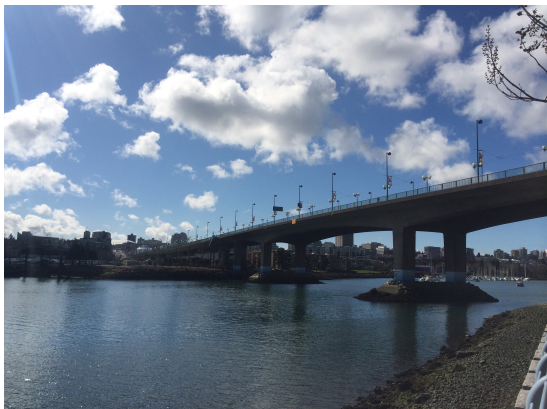
Cambie bridge som sträcker sig över False Creek.
