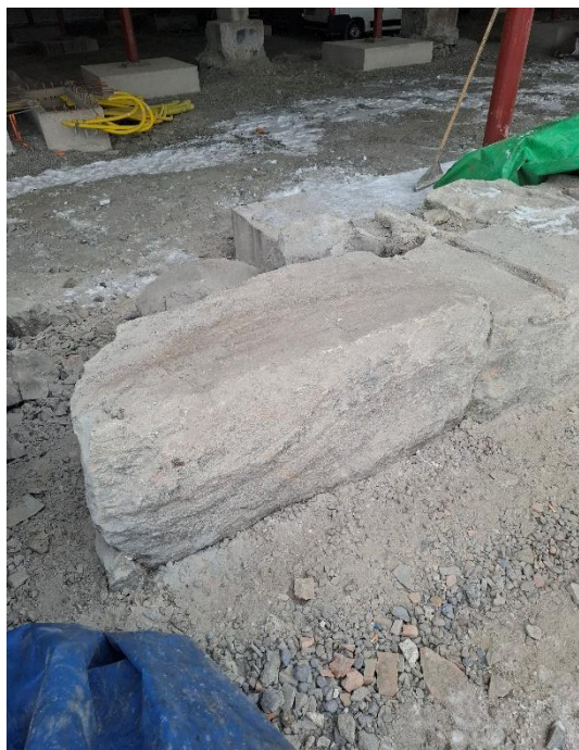
Figur 8 Arbeta av stensockel
