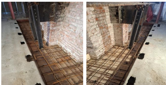
Figur 3 Ursparing innan i gjutning av HD/F
