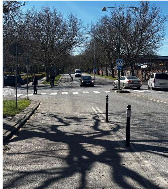
Figur 24. Utformningslösningar med pollare skapar ofta otydliga situationer i korsningar, Scheelegatan. Källa: privat foto
