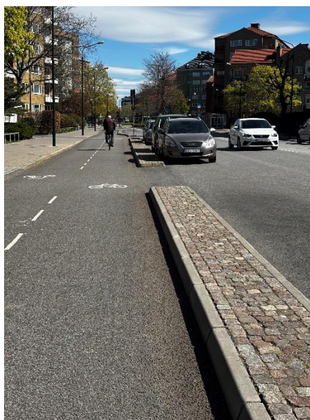
Figur 31. Variant av platsbyggd separationslösning, Tessins väg. Källa: privat foto.
