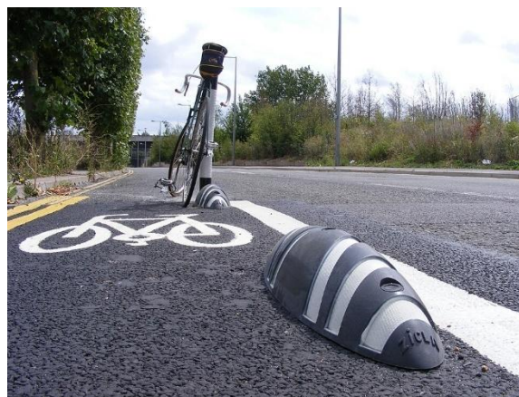
Figur 9. Cykelfält med Zicla traffic segregators på Temple Mills Lane, London. Källa: sludgegulper 2015
