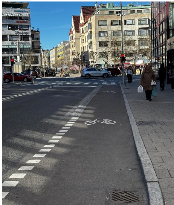
Figur 2. Korsande av vägbana vid Rådmansgatan gjorde platsen problematisk på grund av dålig synbarhet av nivåskillnaden mellan körbana och cykelbana, innan man anlade en rad storgatsten och två rader smågatsten. Källa: privat foto.
