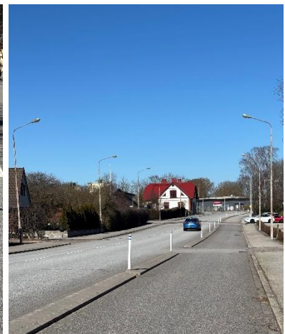
Figur 6. Cykelbana separerad med GCM-stöd och pollare, Cypressvägen. Källa: privat foto.
