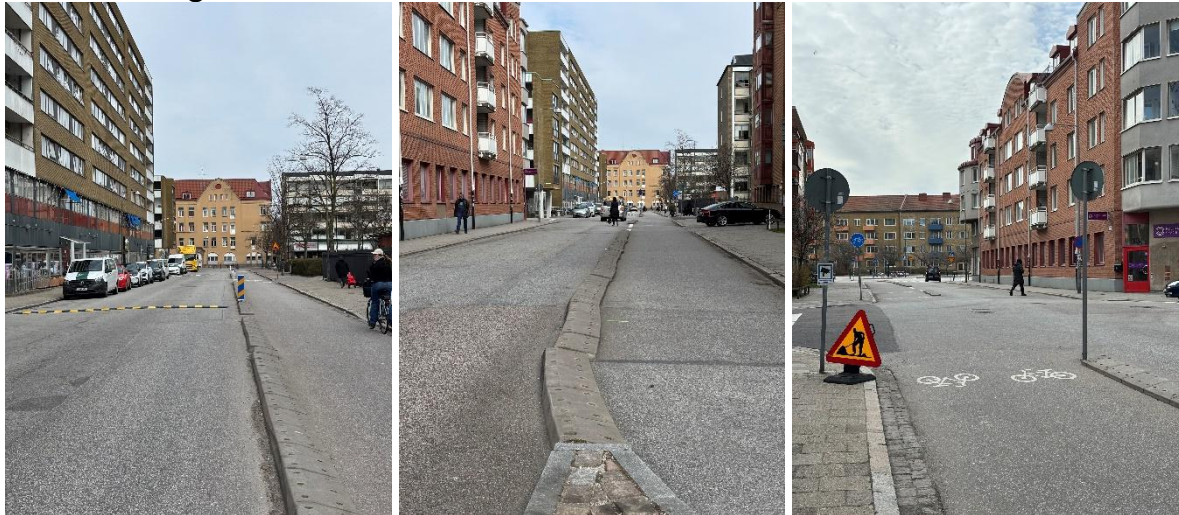
Figur 4.2. Fältbilder från Bangatan. Bilderna visar GCM-stödets placering längs sträckan samt dess anslutning till omgivande gång-, cykel- och körbaneytor. Källa: privata foton..
