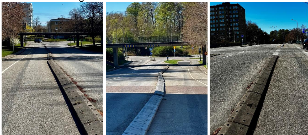
Figur 4.7. Fältbilder från Frölichs väg. Bilderna visar GCM-stödets placering i en miljö där anslutande rörelser, korsningspunkter och gaturummets bredd har betydelse för stödets funktion. Källa: privata foton.
