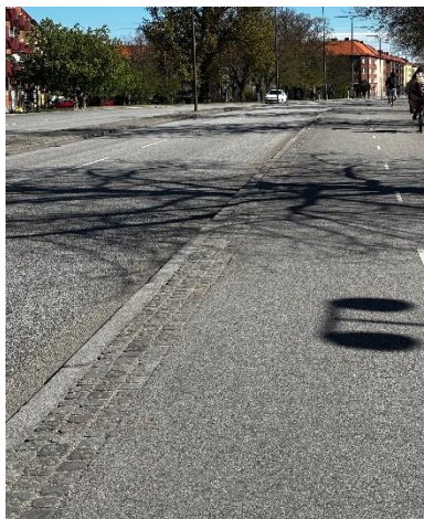
Figur 5. Cykelbana separerad med kantstöd med visning och nivåskillnad, samt smågatsten, Nobelvägen. Källa: privat foto.
