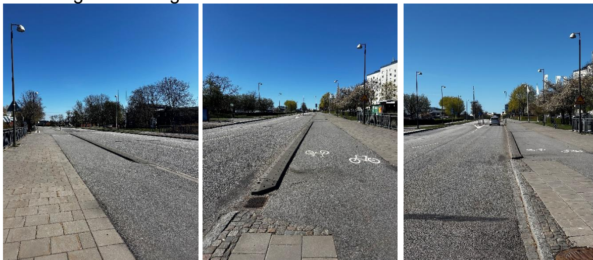
Figur 4.1. Fältbilder från Agnesfridsvägen. Bilderna visar GCM-stödets placering längs sträckan samt dess anslutning till omgivande gång-, cykel- och körbaneytor. Källa: privata foton.
