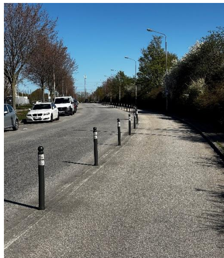
Figur 7. Cykelbana separerad med pollare och målad heldragen linje, Thomsons väg. Källa: privat foto.
