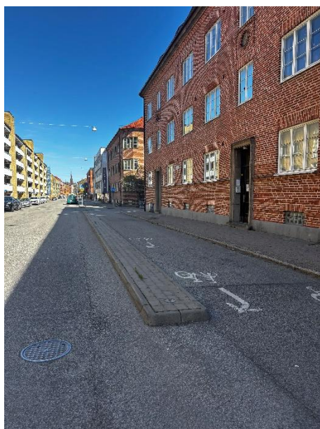
Figur 30. Variant av platsbyggd separationslösning, Disponentgatan. Källa: privat foto.
