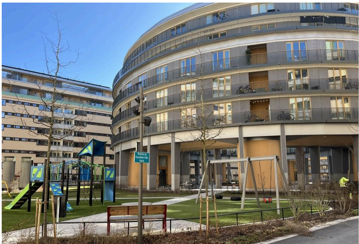
Figur 4. Till höger i bild är det nybyggda huset. Till vänster är det äldre huset med tillbyggnaden ovanpå.
