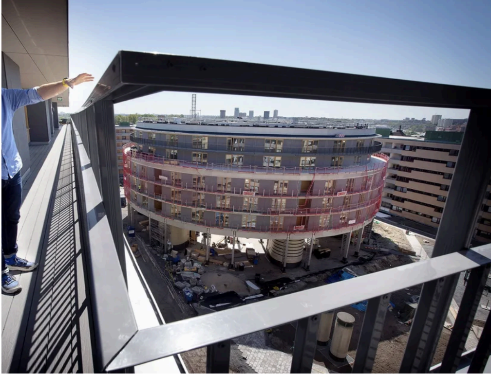
Figur 11. Bilden är tagen från den nya högsta våningen och illustrerar byggnationen av det runda huset på innergården. Foto: Pekka Pääkkö (2024)
