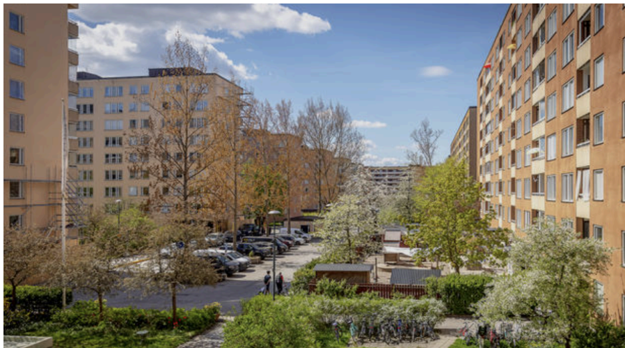
Figur 5. Kvarteret Draken, byggt under samma tid fast på andra sidan Hornsgatan. Källa: Svenskfast (2024)
