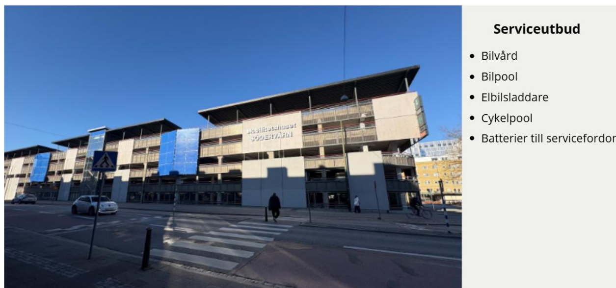
Figur 15. Mobilitetshuset Södervärns fasad och serviceutbud. Bilderna är tagna av författarna.
