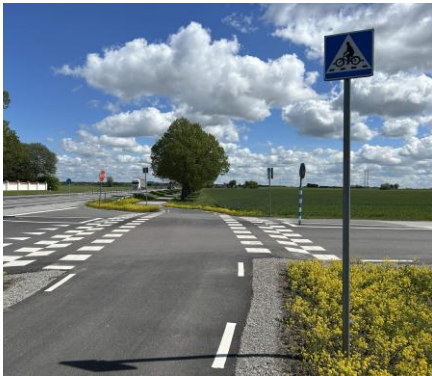
5 Upphöjd cykelöverfart på supercykelvägen Lund-Lomma.
