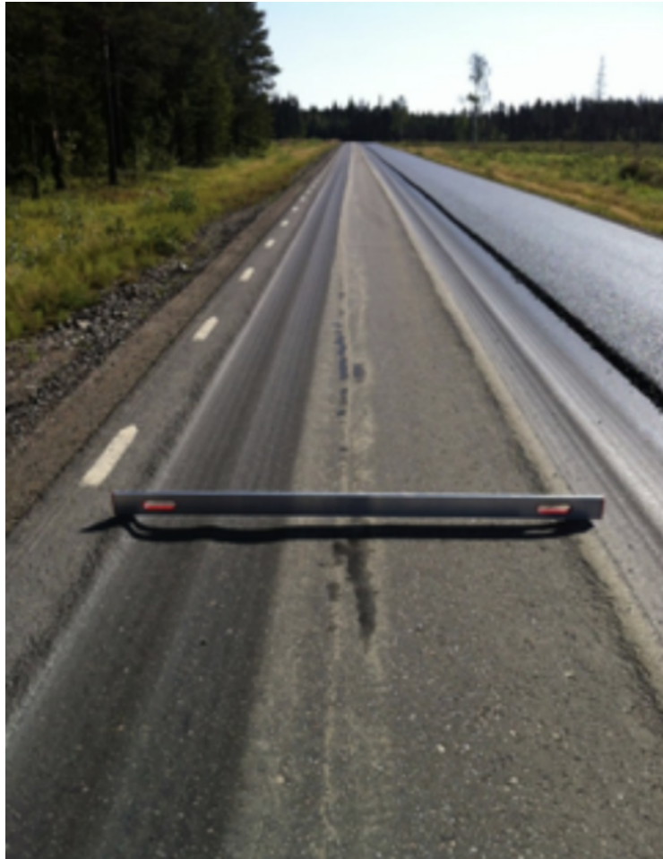
Figur 22. Spårbildning i beläggnigen efter tung trafik (SKR 2019).
