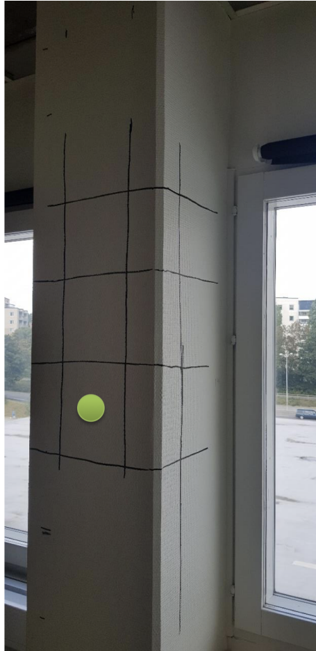
Figur 4.1: Bilden visar en pelare från Kv. Yrket 3. Källa: RISE, Rivningsobjekt från kostnad till resurs: Pilotstudie återbrukspotential för tunga stomdelar i två rivningsobjekt , 2021 [78]. Bild återgiven med tillåtelse.
