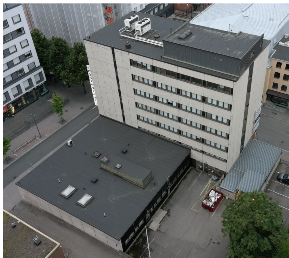
Figur 4.3: Bilden visar donatorbyggnaden i Tampere, Finland. Källa: Swedish country cluster, ReCreate project, Properties and quality of precast concrete elements deconstructed in ReCreate's pilots , 2024 [90], Photo © TAU/Heikki Vuorinen. Bild återgiven med tillåtelse.
