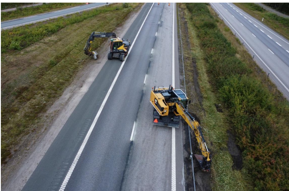
Figur 4. Kantskärning under servicefönster. Foto: Tim Gideonsson
