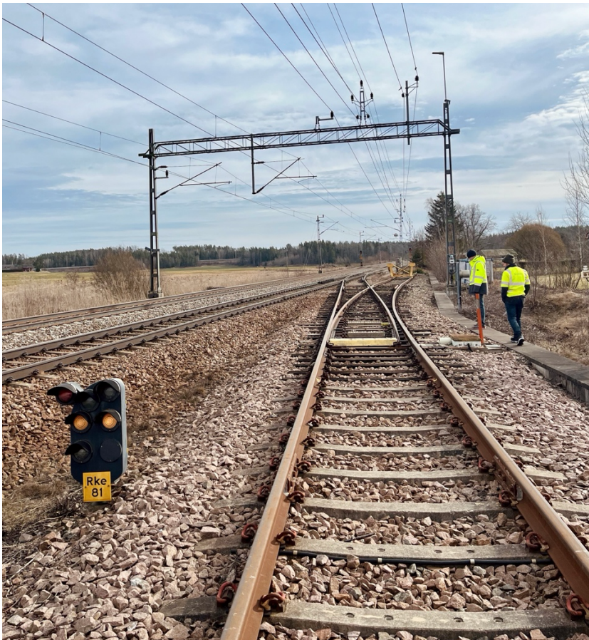
Figur 1: Uppställningsspår med skyddsväxel i skyddande läge. Eget foto
