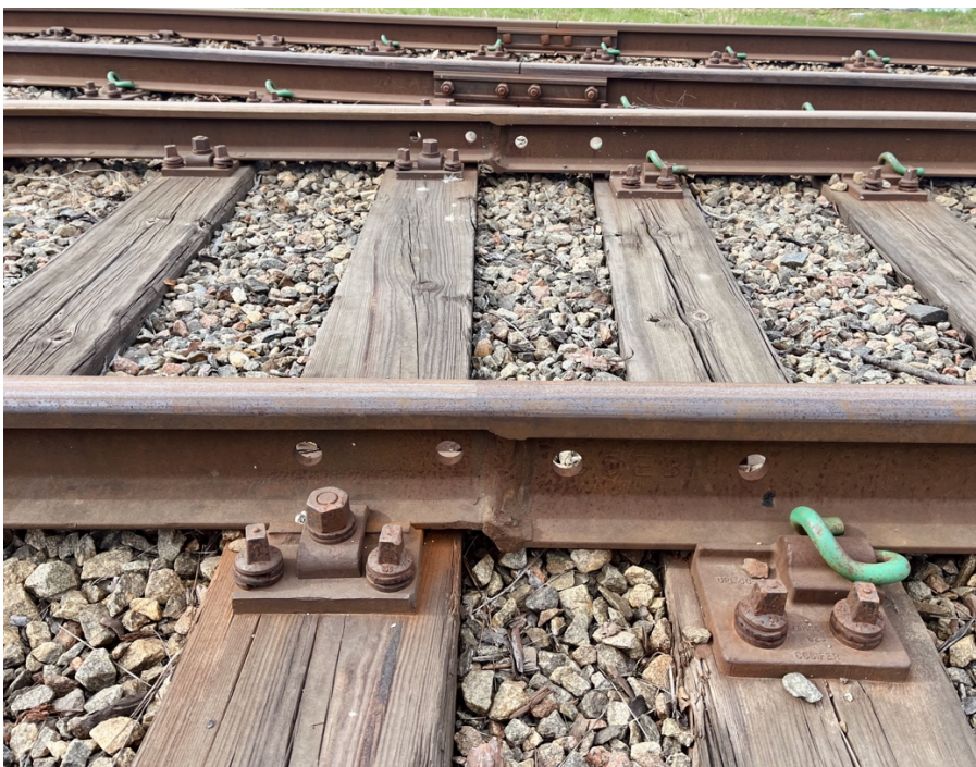
Figur 9: Övergångssvets mellan 43 och 50 kg- räler. Eget foto
