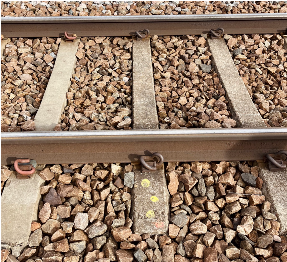
Figur 11: Färgmärkt DEF- sliper med längsgående sprickor. Eget foto
