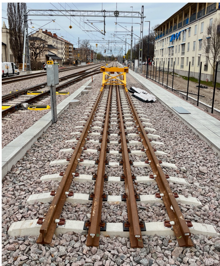
Figur 15: Nybyggt skyddsspår på uppställningsspår med regelmässig stoppbock. Eget foto
