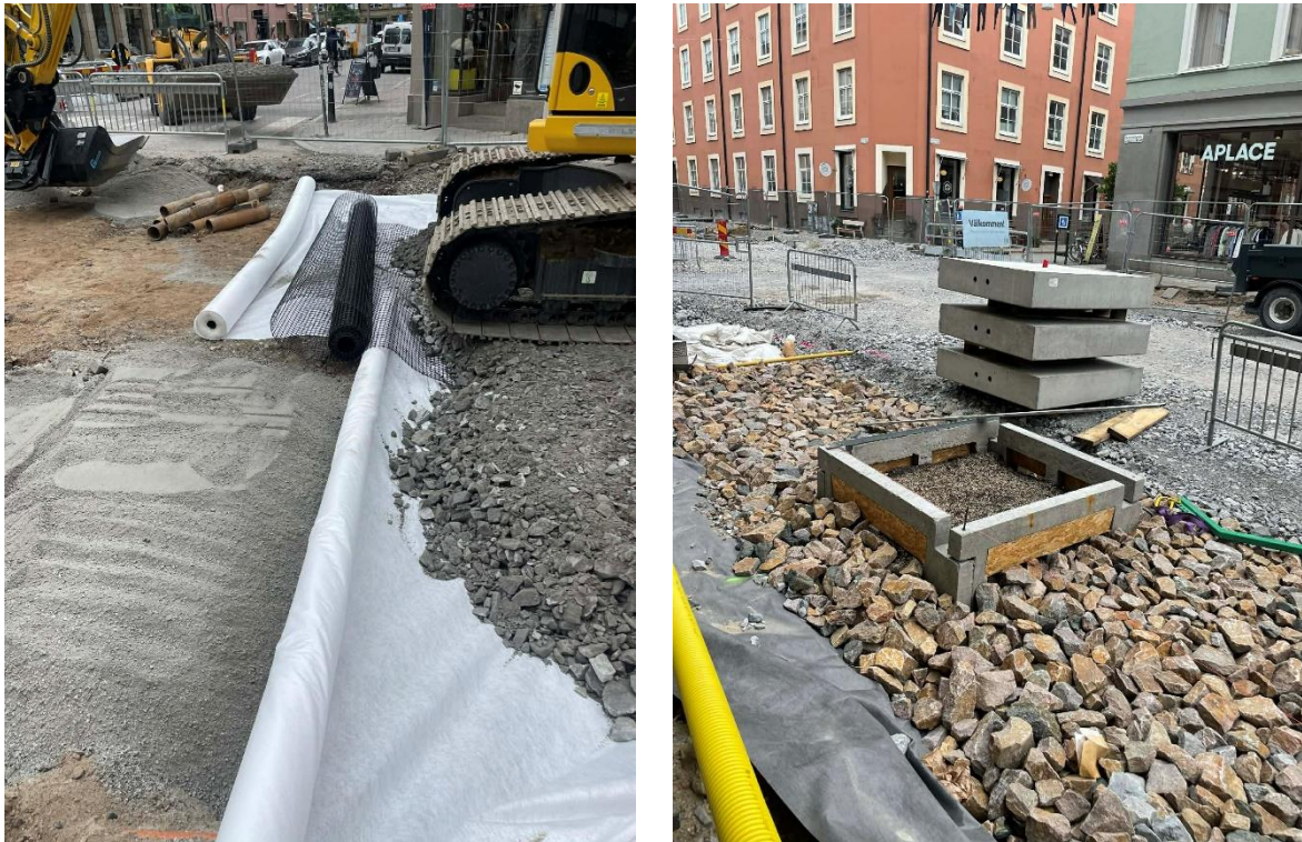
Figur 5: Vänster bild visar installation av fiberduk (vit) och höger bild rotspärr (svart).
