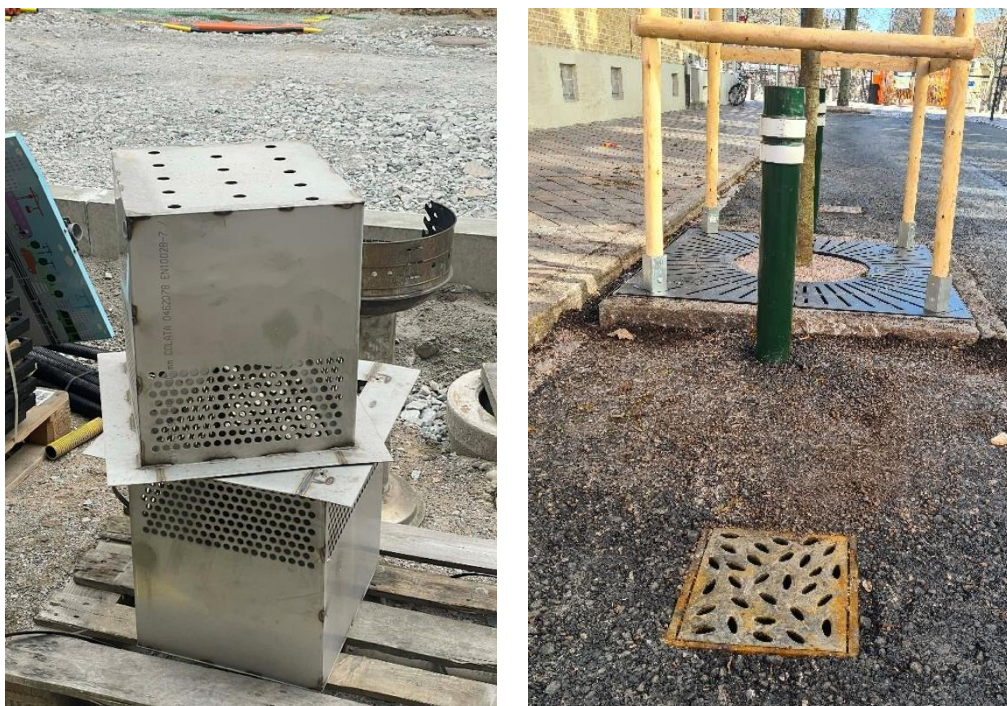
Figur 3: Vänster bild, luftningsbrunn (Sölvesborgsgatan, 2026-03-18). Höger bild, luftningsbrunnar innan installation.
