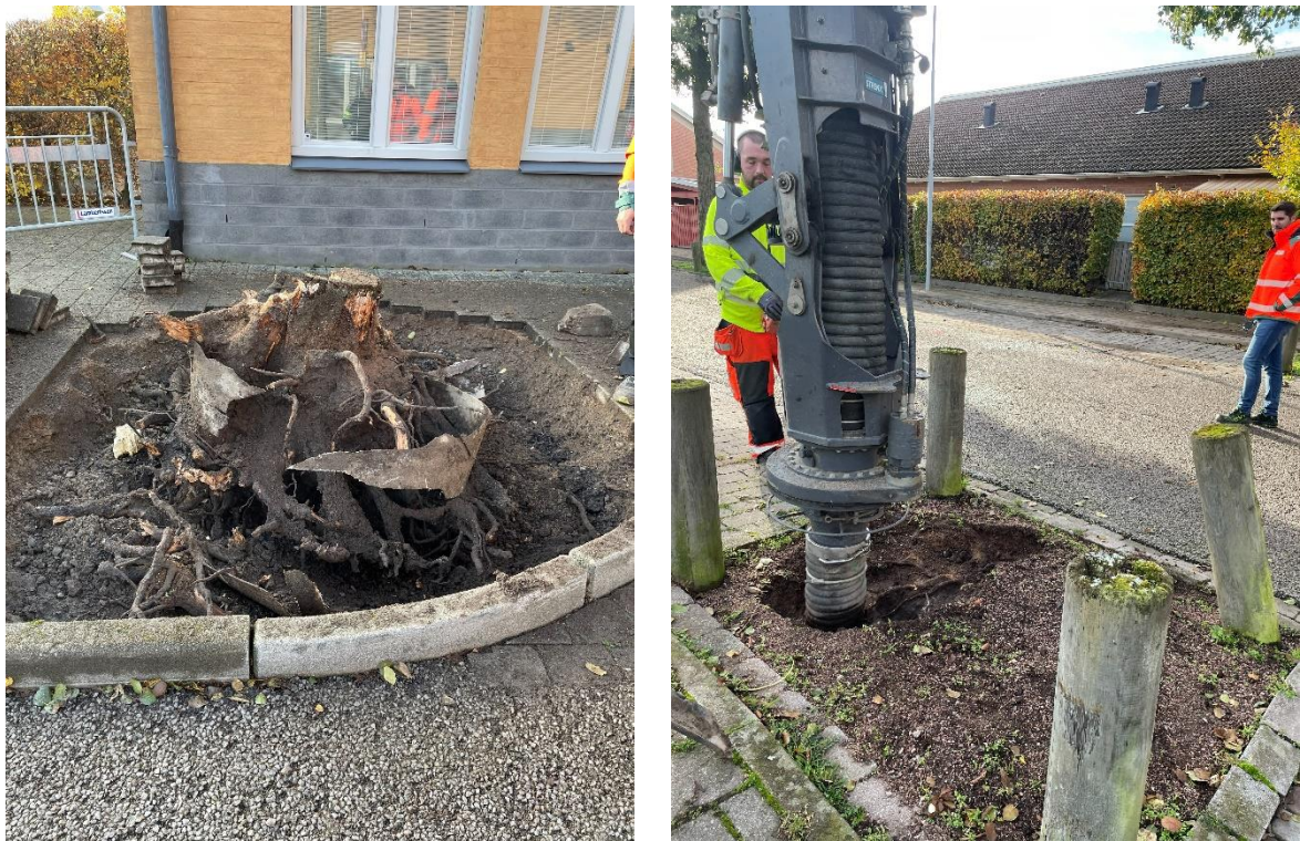
Figur 6: Vänster bild, rötter som spritt ut sig i en växtbädd (Pysslinggatan, 2025-00-03). Höger bild, vakuumschaktning används för att på ett säkert sätt ta bort jord i växtbädd (Pysslinggatan, 2025-00-03).
