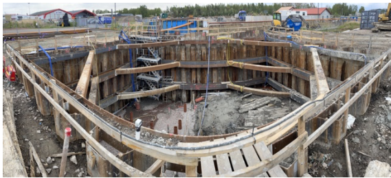
Pumpstation P1 i Kristianstad under utförandefasen.
