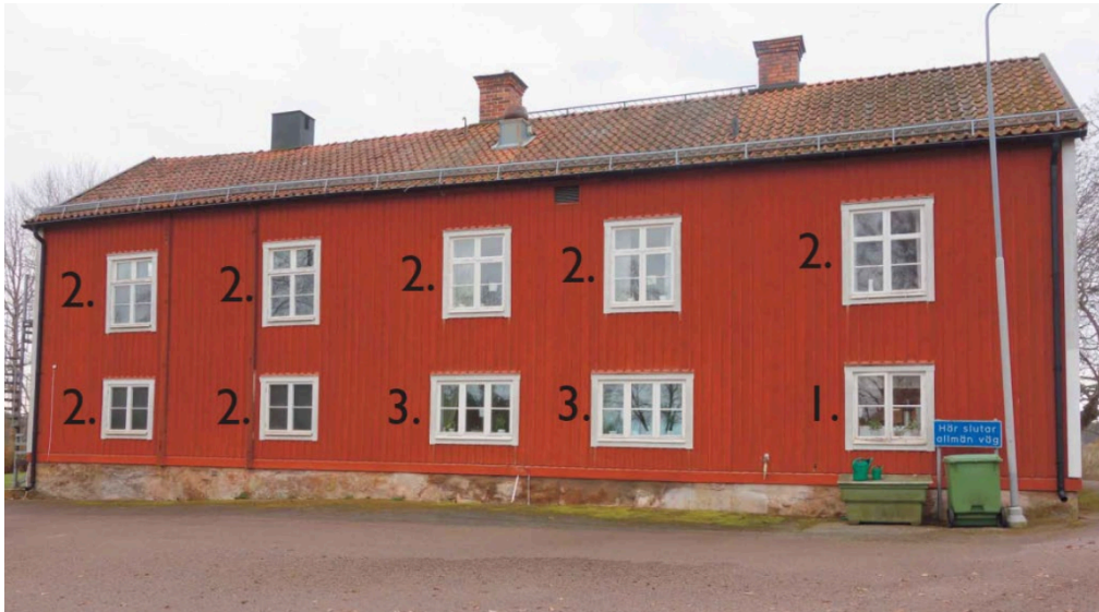
Figur 2: Utdrag ur detaljplan i Bankekind för Svinstad 1:10 och del av 1:9 (0580K-P1646). Bild på byggnaden där fönster på den nordvästra fasaden redovisas från de olika tidpunkterna, nummer 1 är 1930-tal, nummer 2 är 1980-tal och nummer 3 är 2000-tal. På byggnadens nordöstra fasad är samtliga fönster från 1930-tal.
