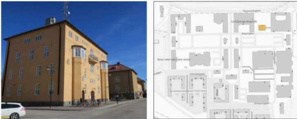
Figur 6: Utdrag från detaljplan i Garnisonen för del av Smedstad 1:21 m.fl. (Kasernområdet etapp 2) (0580K-P1643). Bild på byggnad som beskrivs i Tabell 27 samt karta med gul markering över vart byggnaden är lokaliserad i området.
