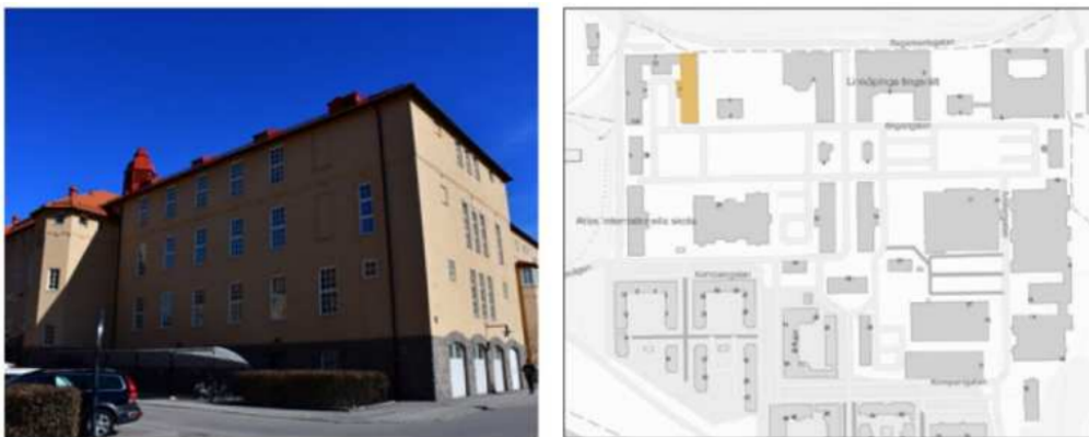
Figur 4: Utdrag från detaljplan i Garnisonen för del av Smedstad 1:21 m.fl. (Kasernområdet etapp 2) (0580K-P1643). Bild på byggnad som beskrivs i Tabell 25 samt karta med gul markering över vart byggnaden är lokaliserad i området.
