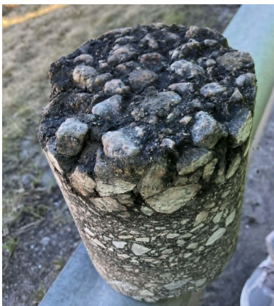
Figur 27: Borrhärd i hjulspår där slitlagret har separerats från bindlagret till följd av sprickbildning. Det översta synliga lagret i figuren är bindlagret.
