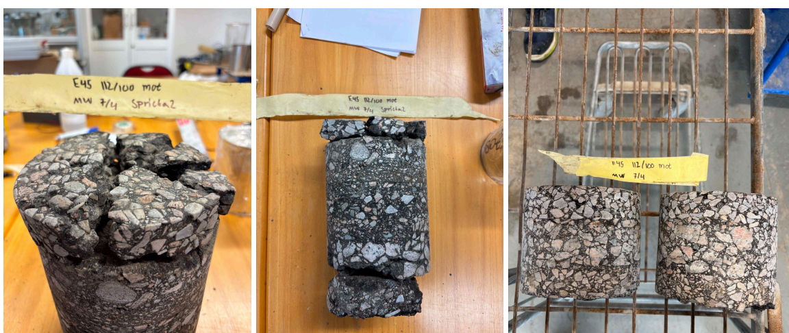
Figur 15: Borrkärnor från E45 sprucken. Den vänstra bilden visar komplett sönderfall av slitlagret. Bilden i mitten visar lageruppbyggnaden där det har varit bristande klistring vilket har resulterat i separation mellan lagren. Bilden till höger visar Ø150 mm borrkärnor mellan hjulspår där sprickor ej förekommer.
