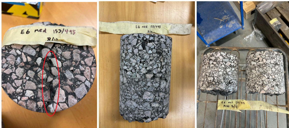
Figur 13: Borrhärdor från E6 spruckna. Den vänstra figuren visar sprickan (röd markering). Figuren i mitten visar lageruppbyggnaden för en borrhärdor i hjulspår där sprickor förekommer. Figuren till höger visar Ø150 mm borrhärdor mellan hjulspår där sprickor ej förekommer.
