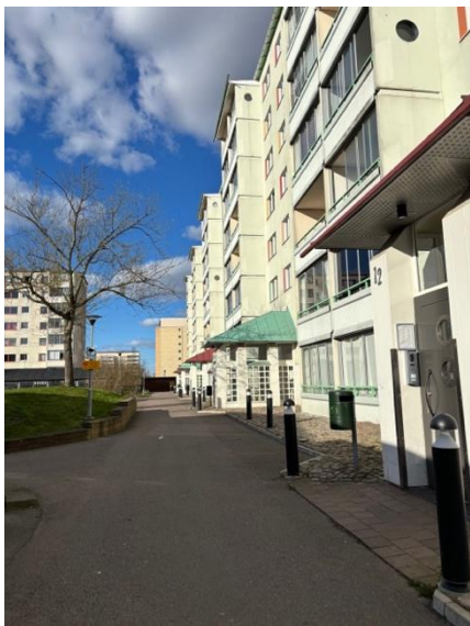
Foto 11. Åttavåningshus i putsad betong i ljusgrå och inglasade balkonger.
